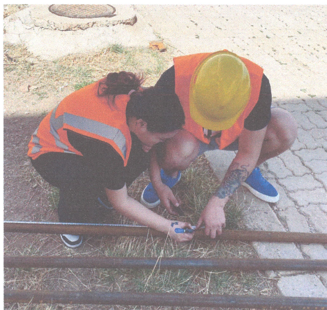
Ган төмөр тайрхад бэлтгэн хэмжилт хийн тэмдэглэгээ хийж буй байдал
