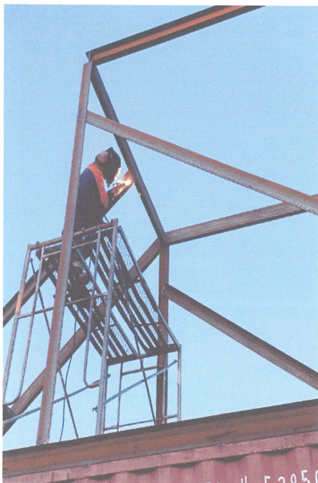
Шатны угсралт хийгдэж буй байдал
