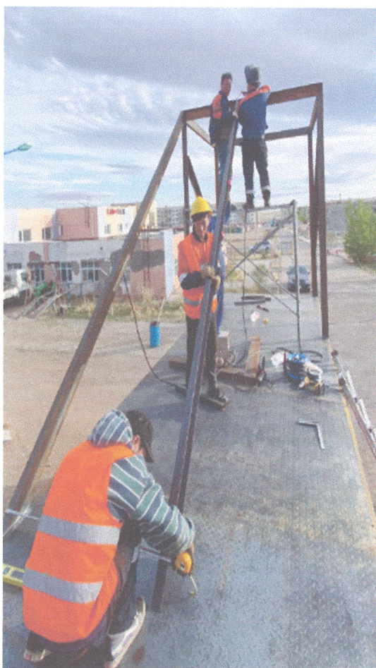
Шатны угсралт хийгдэж буй байдал
