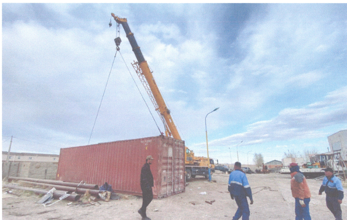
Төсөлт ажил хийгдэх контейнер байршуулж байгаа байдал
