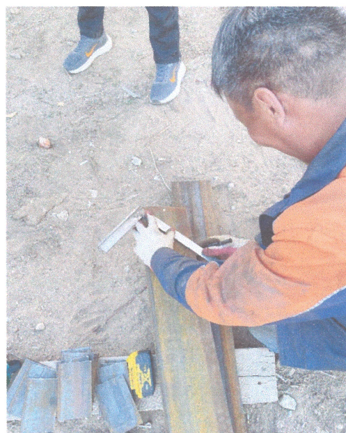
Ган төмөр тайрхад бэлтгэн хэмжилт хийн тэмдэглэгээ хийж буй байдал
