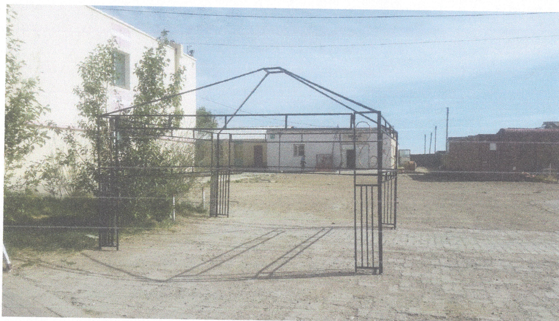
Бэлэн болсон багана, дээд тушаа ,дунд тушаагаа хооронд угсарч тэгш гадаргууд асраа босгож үзсэн.
