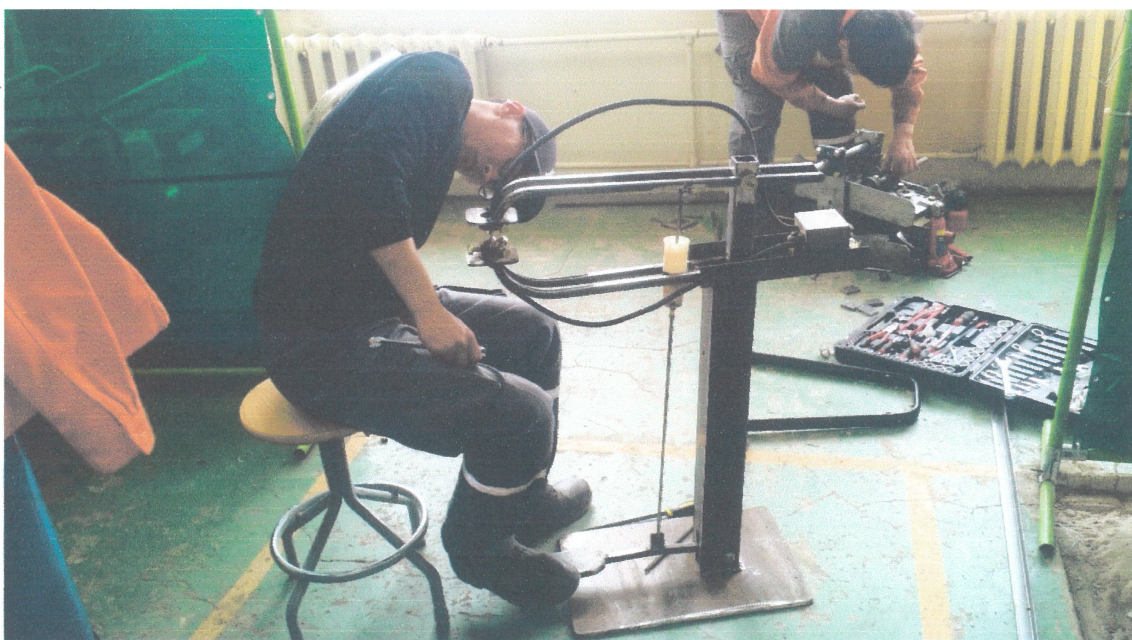
Трансформатор болон зэсэн хошуугаа рамандаа угсарж тохируулж засвар хийгдэж байна.
